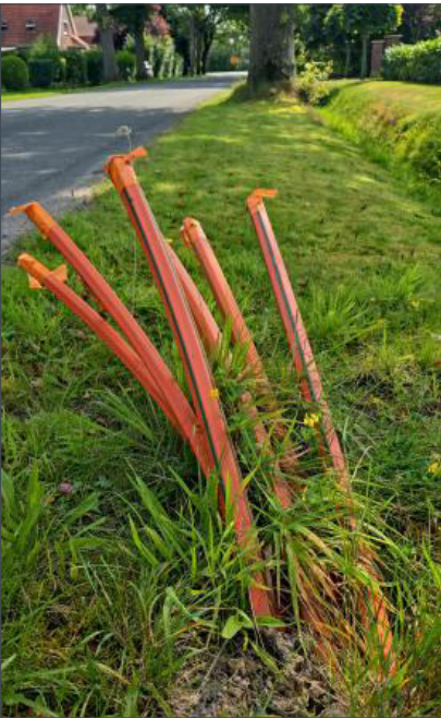
Leerrohre an der Uthörner Straße in Wittmund-Leerhabe. Foto: Fa. epcan GmbH
