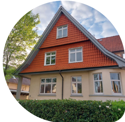
Die neue Geschäftsstelle der Naturschutzstiftung befindet sich in der Bahnhofstraße 29 in Varel. Foto: Tobias Pelz
