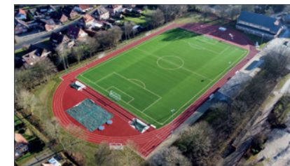
Saniertes Stadion Peldemühle in Esens
