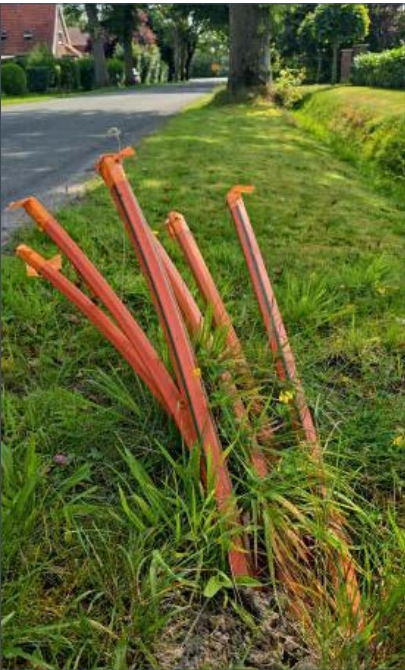
Leerrohre an der Uthörner Straße in Wittmund-Leerhafe. Foto: Fa. epcan GmbH
