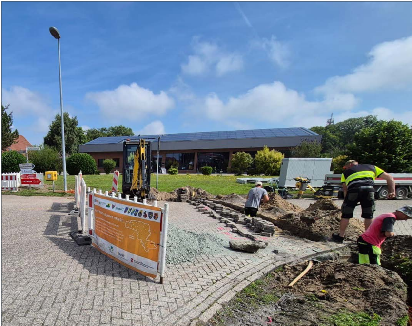
Glasfaserverlegung im Gewerbegebiet Süd in Esens. Foto: Fa. epcan GmbH
