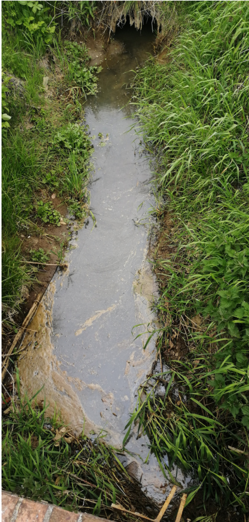
Abbildung 3: Vor dem Kopfbauwerk (unten) versickerndes Wasser
