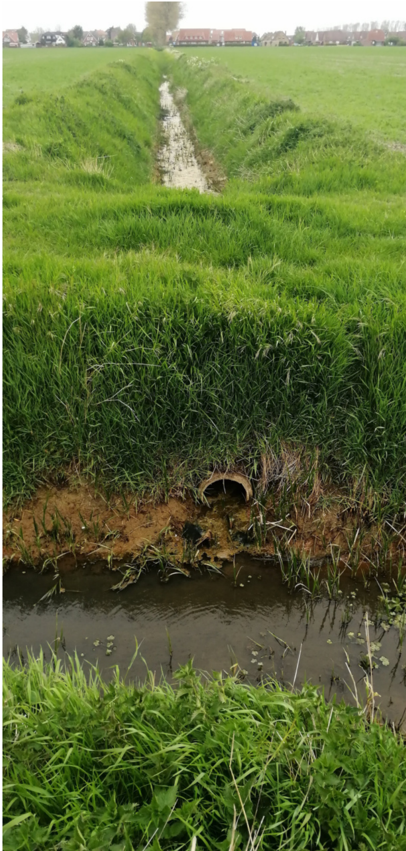
Abbildung 6: Verrohrung Bahnhofsleide/Stichgraben (hinten)
